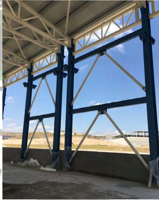
Şekil 1. Ters-V çapraz düzenine sahip iki katmanlı çaprazlı çerçeve
